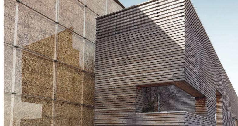
**Biohof Achleitner, Eferding.** Energieoptimierung noch vor dem ersten Spatenstich: Der Biohof Achleitner im oberösterreichischen Eferding wurde mithilfe einer Computersimulation (TAS) modelliert. Das vom Ingenieurbüro IPJ entwickelte Energiekonzept nutzt das Erdreich als Wärme- und Kältequelle. Für die Dämmung der großen Halle wurde Stroh als nachwachsender Rohstoff verwendet.
